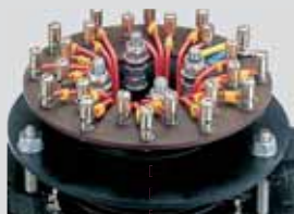
Разводка на плате выводов
